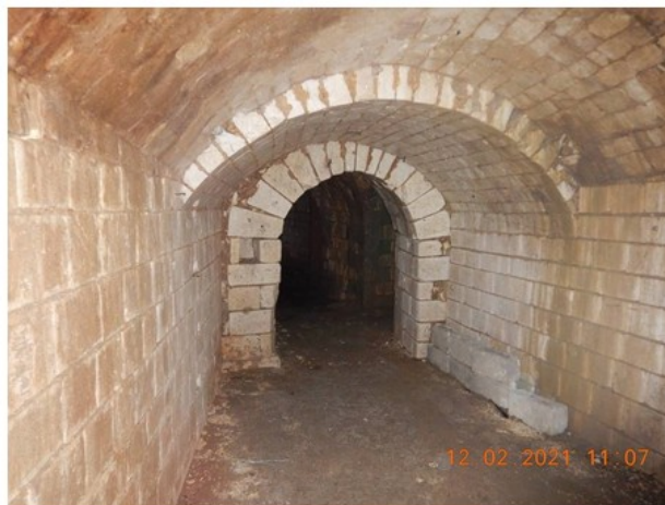
Photo d'une galerie – DDTM 62
