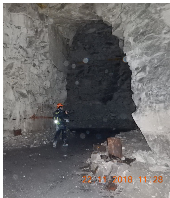
Photo d'une carrière d'Arras
