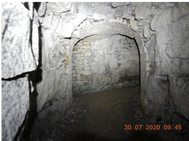
Photo d'une galerie – DDTM 62
