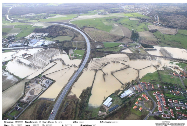
Inondations de la Liane de 2009 sur la commune d'Isques
