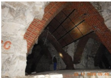
Réseau souterrain Nelson - Arras
