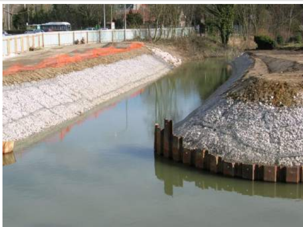
Recalibrage de la Liane (Pont de Briques)
