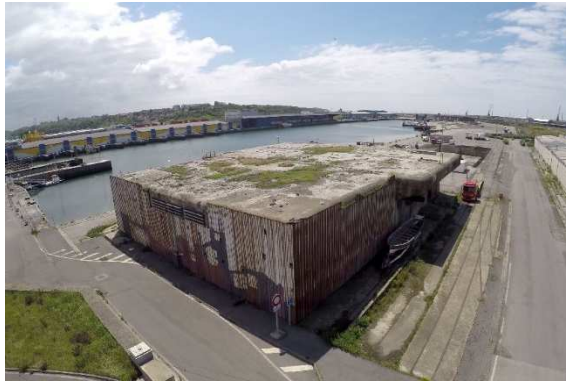
Site du blockhaus au nord de l'écluse Loubet.
