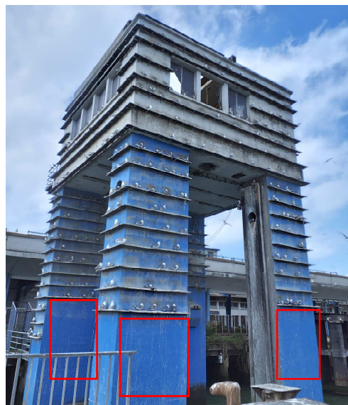
Localisation des plateformes supplémentaires (encadrés rouges) sur la tour PP3.
