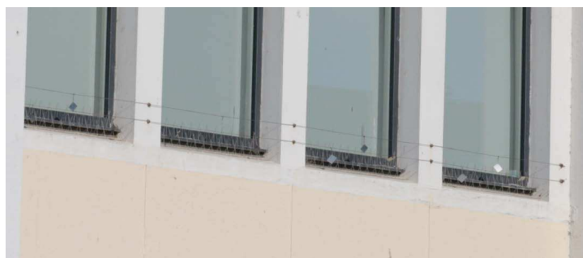
Figure 15 : Installation d'un dispositif triple : pics, câbles non électrifiés et miroirs réfléchissants (Source : A. Ward).
