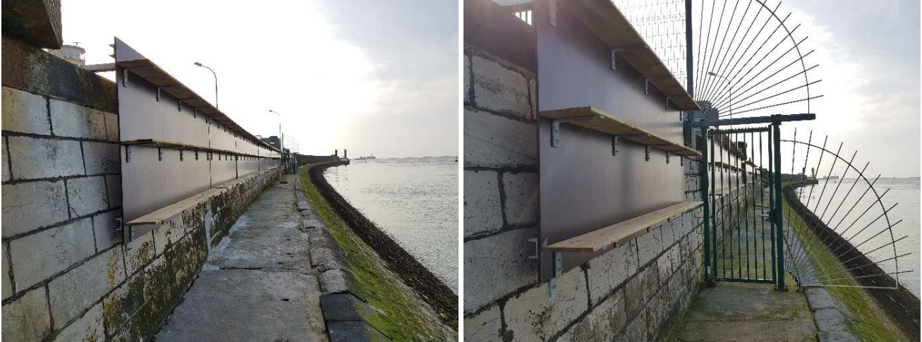
Figure 29 : Plateformes de nidification installées par la région Hauts-de-France au niveau de la jetée sud-ouest (Source : Biotope, 2018).
