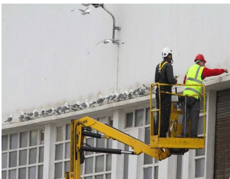
Figure 23 : Installation d'un dispositif anti-nidification (câble électrique) sur un habitat de mouettes tridactyles (bâtiment Continental Nutrition, rue de Nemours) (Source : A. Ward).
