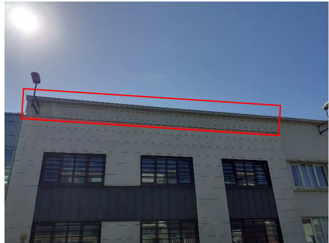
Figure 22 : Installation d'une plaque inclinée en aluminium sur l'hôtel communautaire empêchant les mouettes de nicher.
