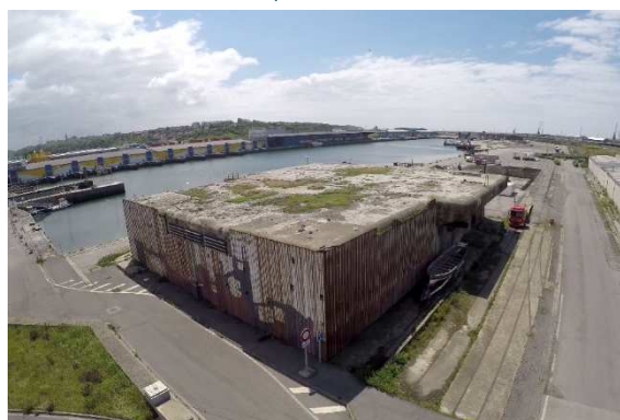
Figure 33 :Site du blockhaus au nord de l'écluse Loubet.
