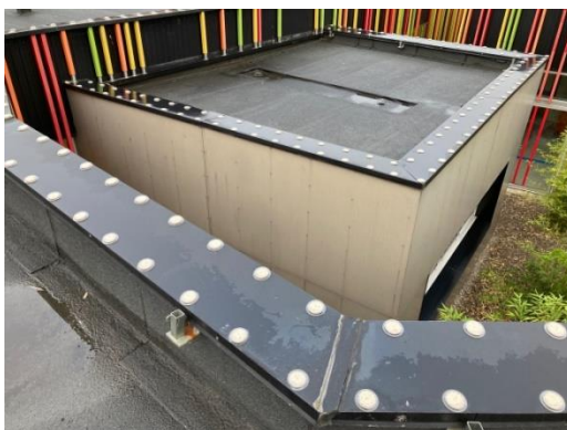
Figure 3 - Coupelles de gel répulsif en place sur la toiture du multi-accueil Arc-en-Ciel (source : interne)
