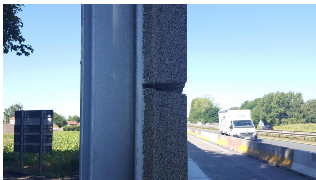
Détail de l'écran – type Béton – bois absorbant
