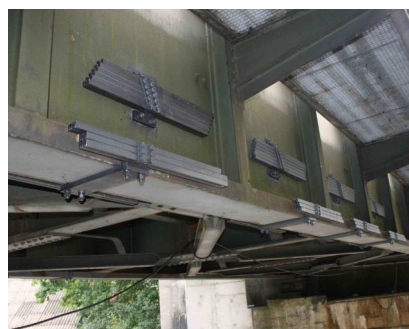
Absorbeur sur platelage
