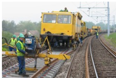
Longs rails soudés sur traverses béton
