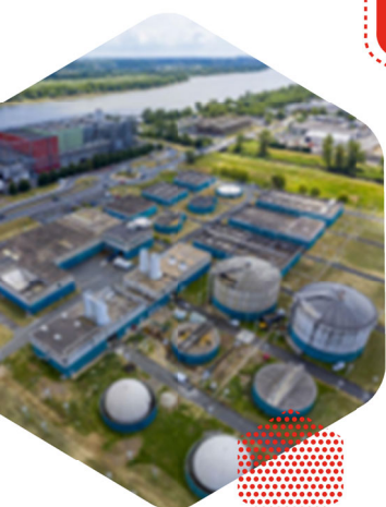
Station d'épuration des eaux usées Clos de Hilde
