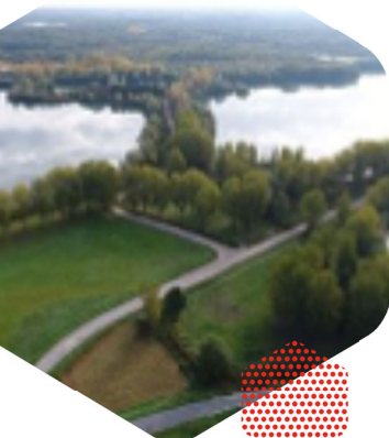
Le territoire d'implantation de la digue et la station de pompage
